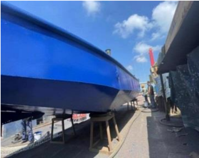
图 3 水性石墨烯重防腐涂料底漆涂刷完成
